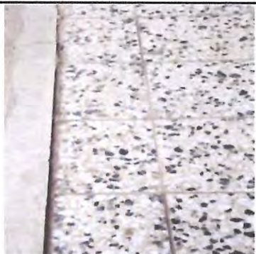
Foto 3: PISO Sustitución de piso de granito por piso cerámicos antidelizante, incluyendo preparación de superficie y nivelación. En area de corredor
