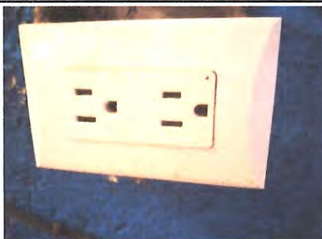
Foto 9: REPARACIÓN DE SISTEMA ELÉCTRICO
