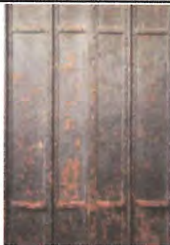
Foto 15: MANTENIMIENTO A PORTONES
