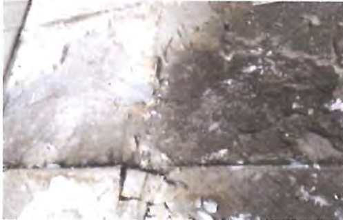
Foto 13: LOSA DE PATIO
