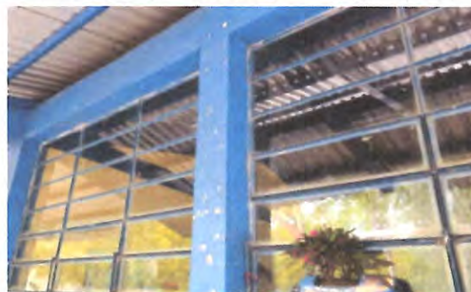
Foto 6: VENTANAS Sustitución de ventanas; sistema de apertura: Corredizas. Perfiles color blanco estandar. Material del marco: PVC Material de la ventana: Vidrio, sellado perimetral.
