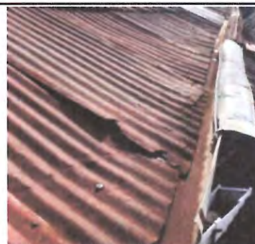
Foto 10: CUBIERTA DE LÁMINA
