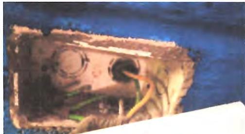
Foto 7: REPARACIÓN DE SISTEMA ELÉCTRICO
