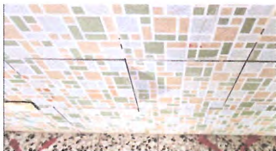
Foto 5: PISO Sustitución de piso de antidelizante por piso cerámicos antidelizante, incluyendo preparación de superficie y nivelación. En fachada de pared de aulas
