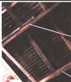
Foto 11: ESTRUCTURA DE TECHO
