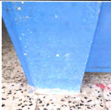
Foto 1: PINTURA EN MUROS INTERIOR Y EXTERIOR Preparación de la superficie y aplicación de pintura a dos manos, en paredes exteriores del establecimiento.
